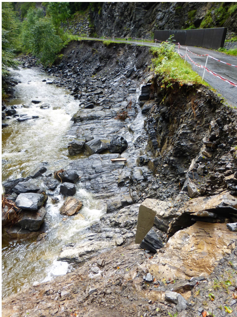
Danni agli argini / Scarpata a Bochtecher (©UFAG)
