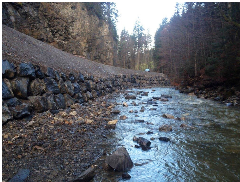
Ripristino degli argini / Scarpata a Bochtecher (©UFAG)
